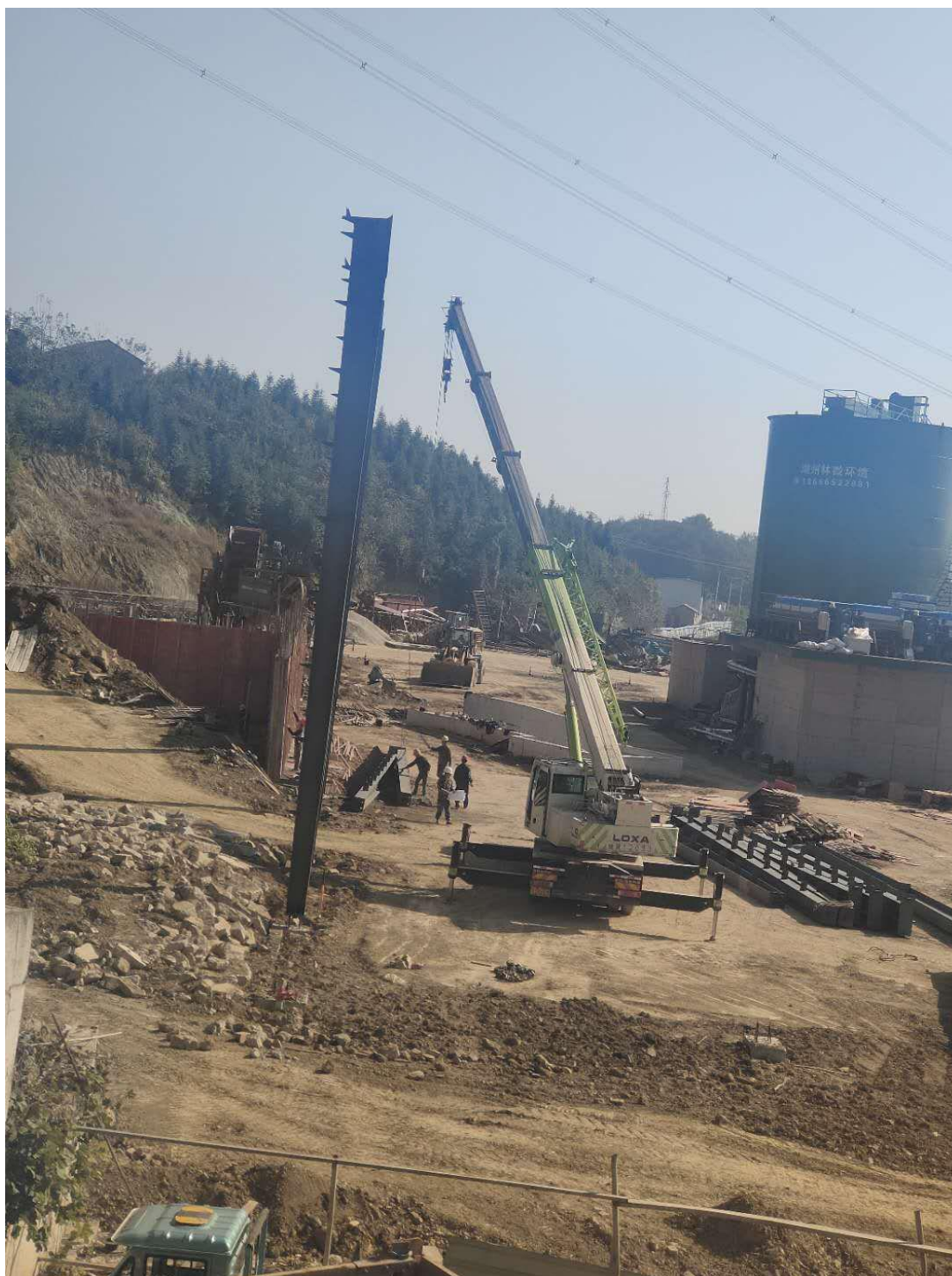
钢构厂房钢构吊装
