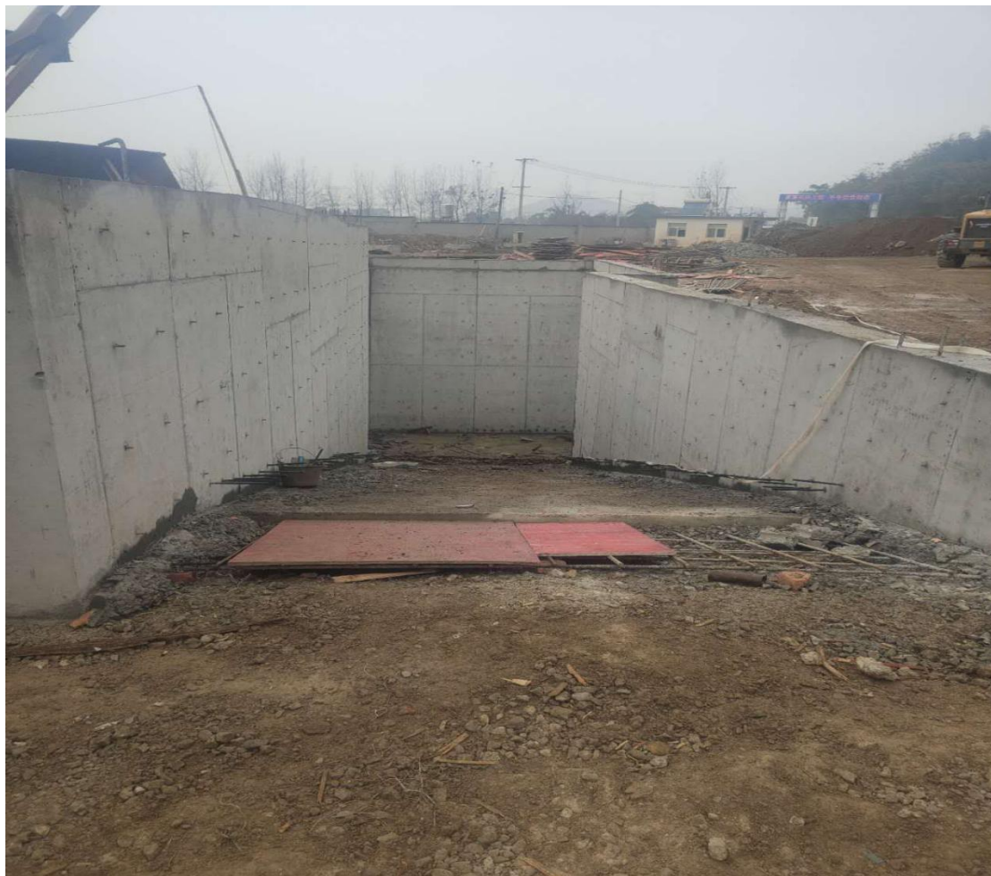
部分设备基础完工
