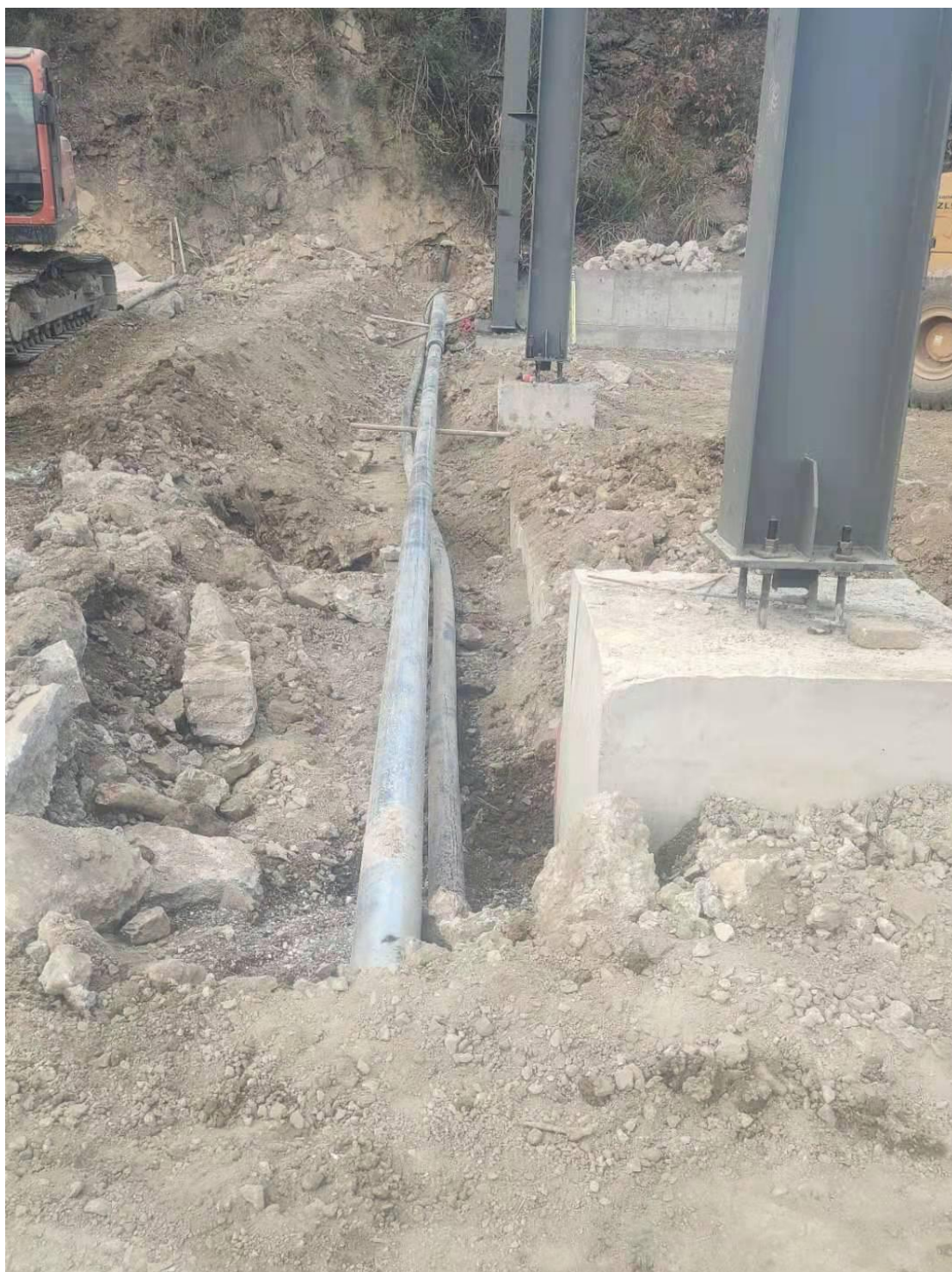
喷淋水管安装
