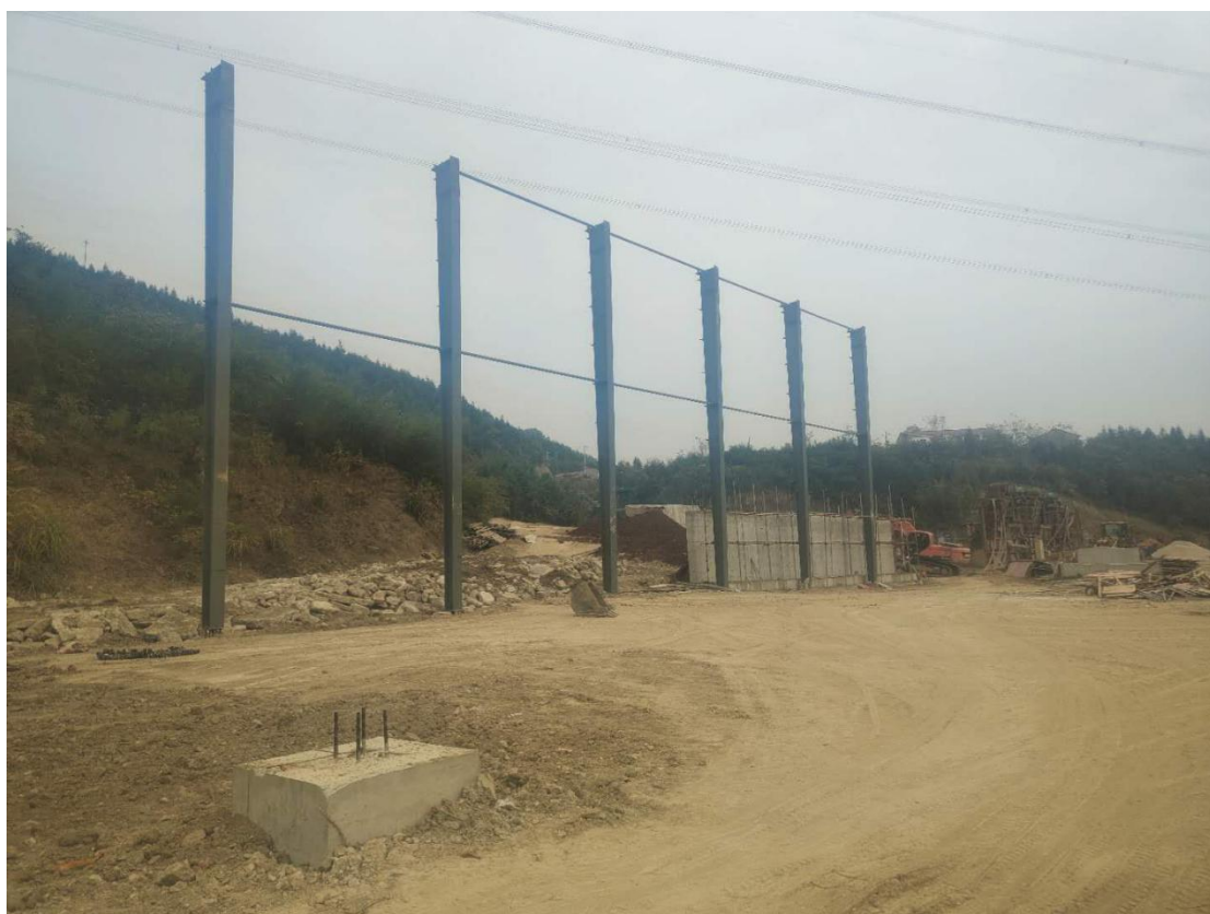
部分钢构厂房钢结构吊装
