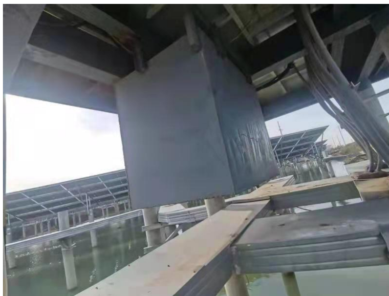
图 2-3 箱变底部储油箱示意图
