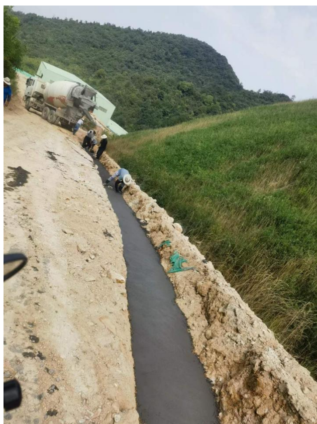
矿山三号采区淋溶水至 1#沉淀池专用水沟和管道改造中后
