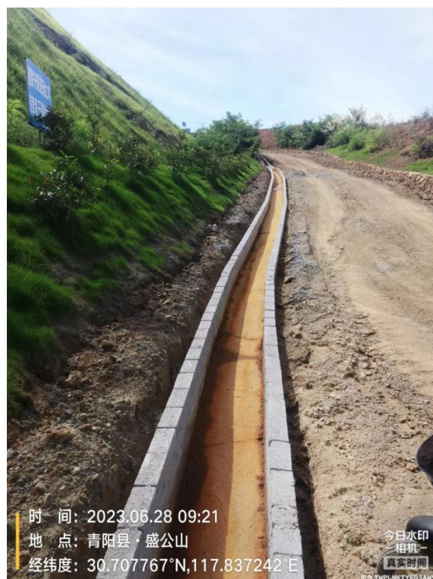
矿山三号采区淋溶水至 1#沉淀池专用水沟和管道改造中后
