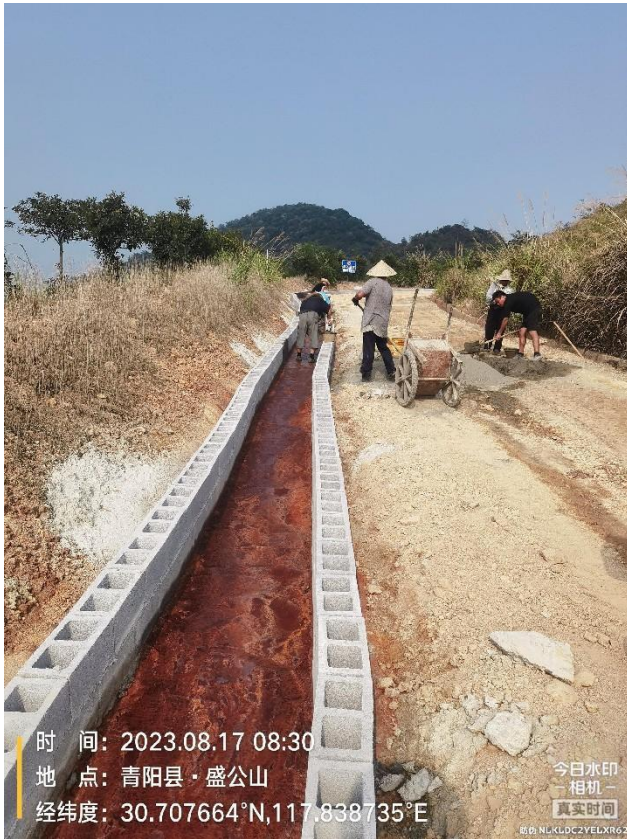
临时堆放场地水沟硬化过程
