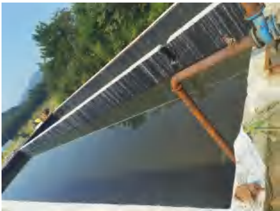
污水处理站（内壁和池体使用 HDPE 防渗膜） 说明：池体中的水是雨水
