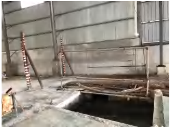
洗车台和洗车废水沉淀池
