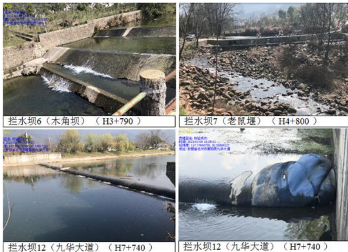
图 3.1.2-6 九华山风景区河段干流涉河建筑物破损现场照片
