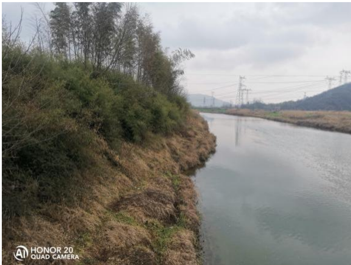
图 2-4 河道左岸岸坡冲刷严重现状图
