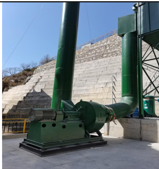
空压机减振基座和除尘风机隔声包裹
