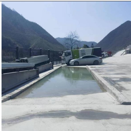
轮胎冲洗点和车辆冲洗站
