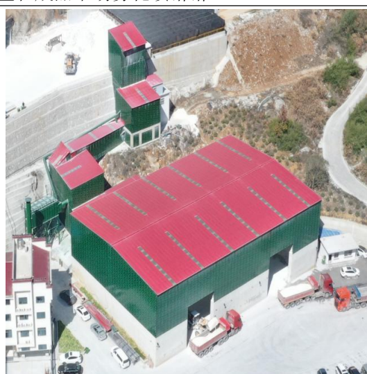
破碎筛分车间和皮带机输送廊道钢结构封闭
