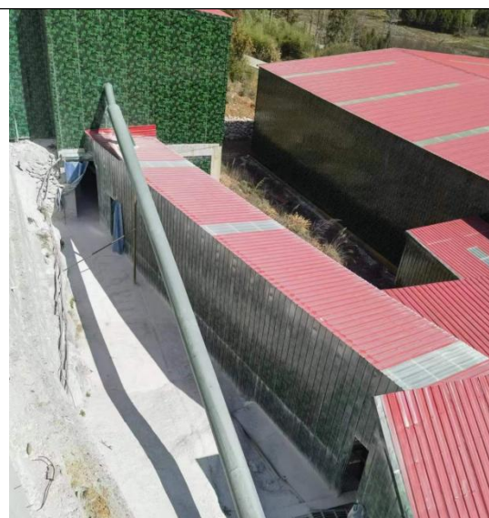
粗碎厂房、筛分厂房钢结构封闭
