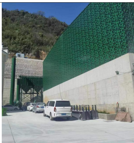
粗碎厂房、筛分厂房钢结构封闭
