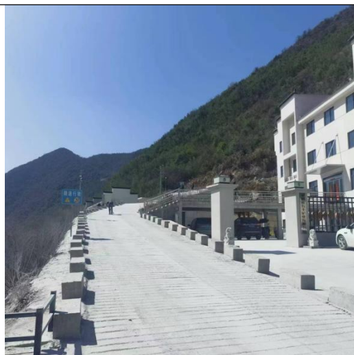
工业场地及运输道路水泥硬化
