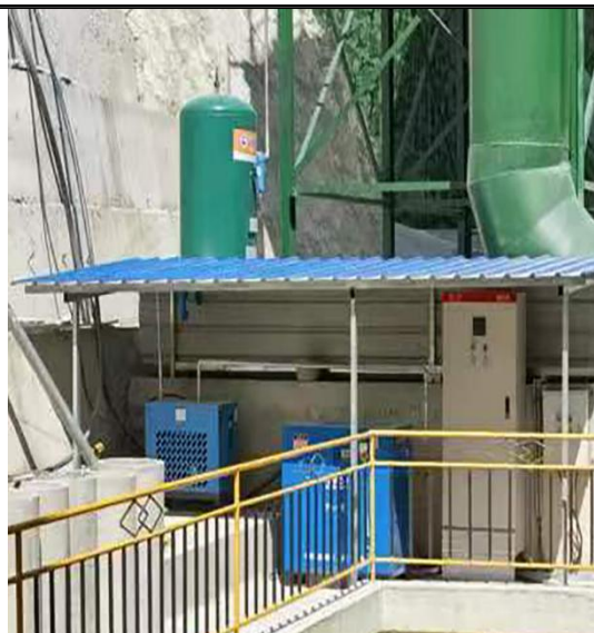
空压机减振基座和除尘风机隔声包裹
