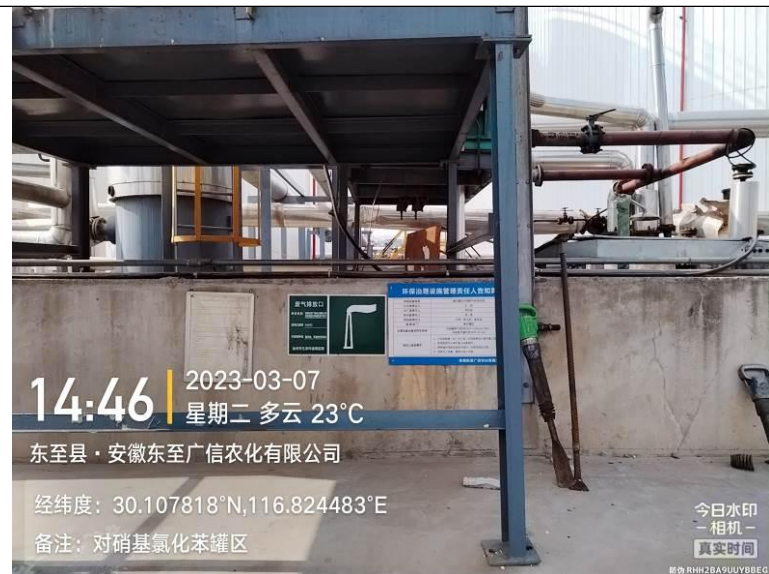
“2 级水吸收”，DA022 排气筒（对硝基氯化苯罐区）
