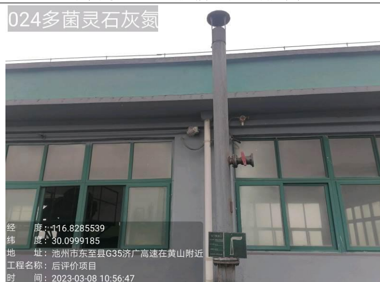
“布袋除尘+水喷淋”，DA024 排气筒（多菌灵）
