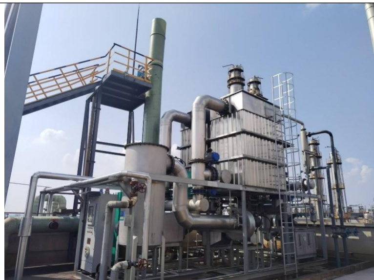
“冷凝+活性炭纤维吸附”设施，DA017 排气筒（对（邻）硝基氯化苯）
