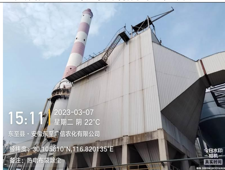
“炉内喷钙+湿法脱硫+SNCR脱硝+电袋除尘”设施，DA001/DA002 排气筒（热电联产）
