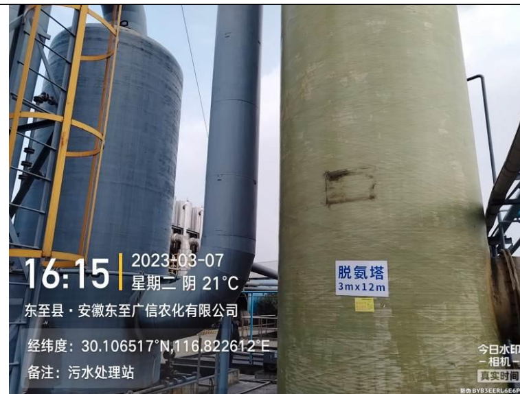
污水处理站脱氨排气筒，DA106 排气筒
