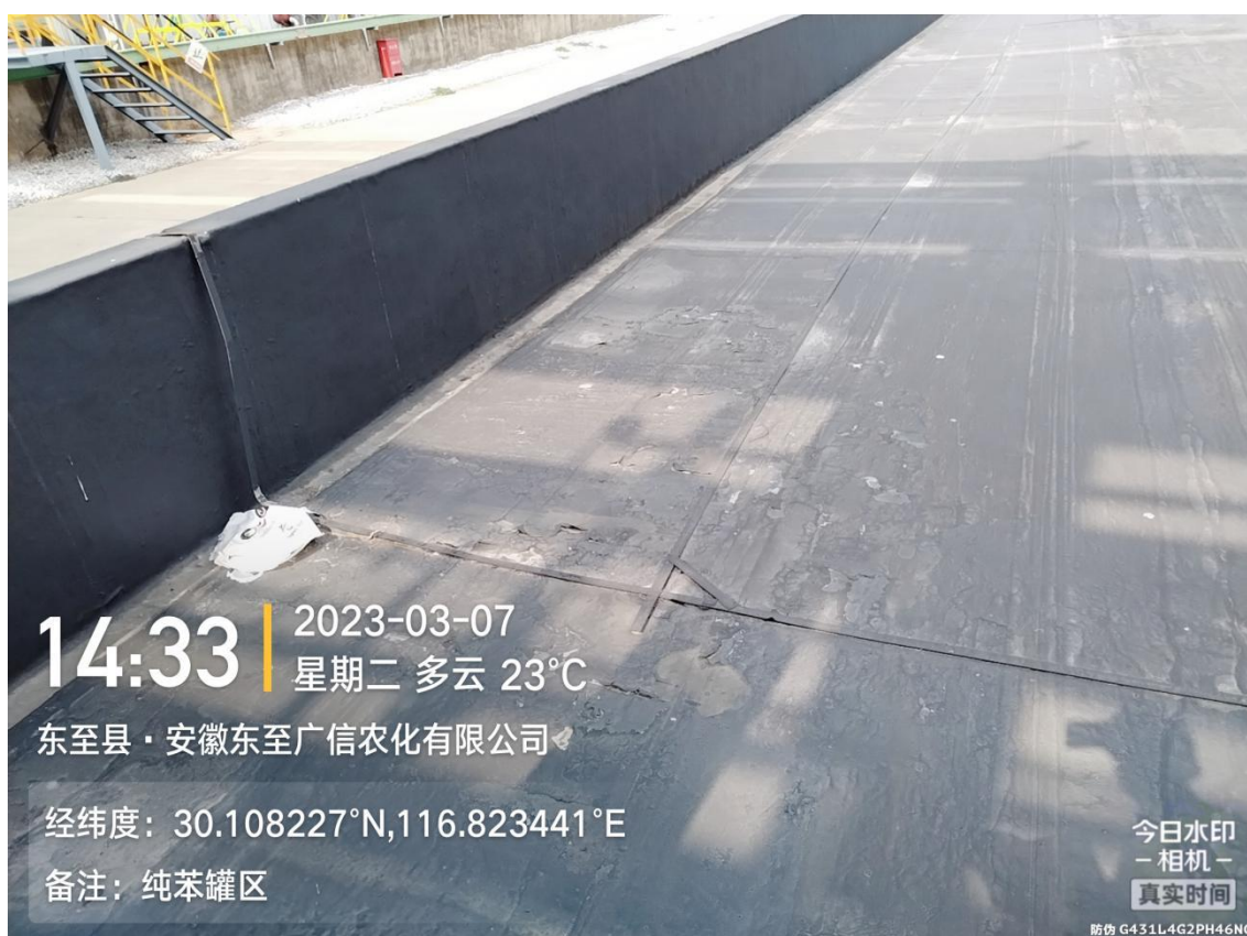
图 7.1.1-1 纯苯罐区环氧地坪破裂
