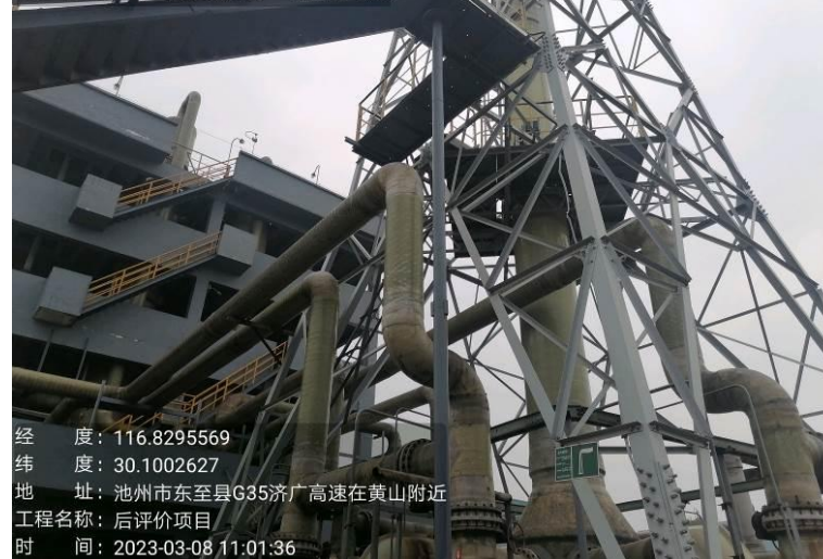
“1 级降膜吸收+4 级 SN7501 催化剂破坏+2 级碱吸收”设施，DA020 排气筒
