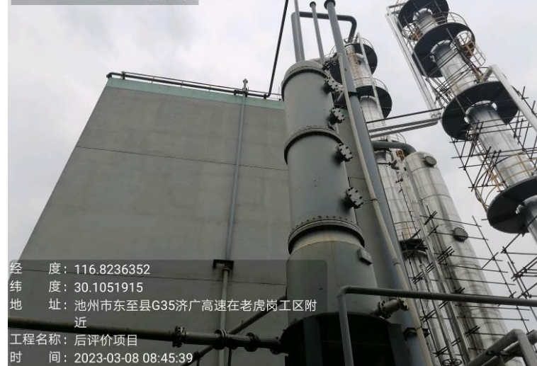
“冷凝吸收+母液吸收+活性炭吸附”设施, DA029 排气筒
