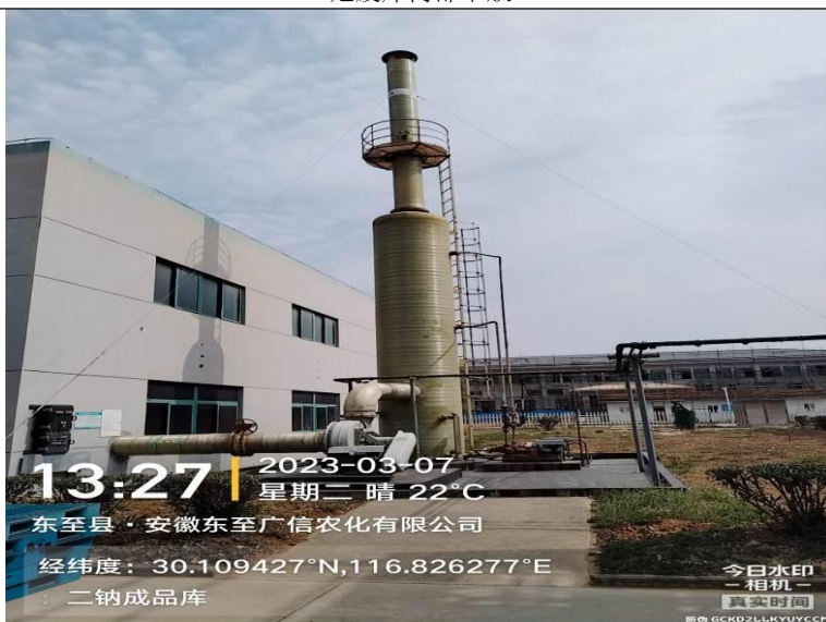
采用“1级酸喷淋”设施，DA113排气筒（二钠成品仓库）
