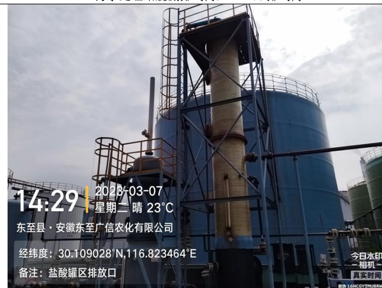
盐酸罐区排气筒，DA107 排气筒
