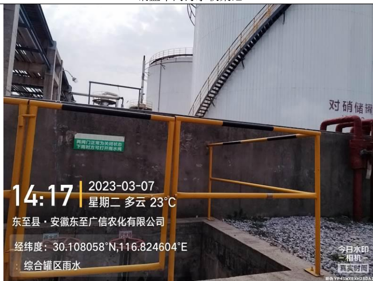
综合罐区雨污分流阀门井
